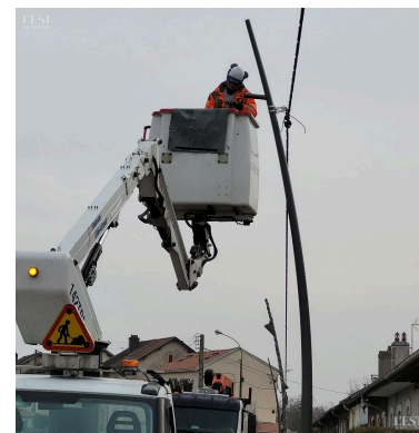
La pose des lampadaires rue Pierre-et-Marie-Curie a été délicate.
