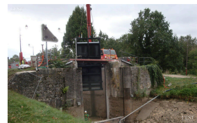
La descente de la porte de l'écluse.
