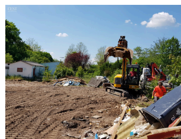
Les travaux de démolition et nettoyage des premières parcelles du Pâtis des Iles ont débuté le 25 avril. Photo ER /Alain THIESSE
