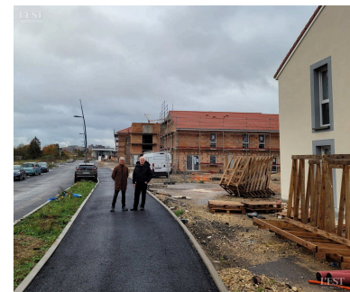
Les adjoints Jean-François Bellotti et Joël Boudevin, particulièrement concernés par ces travaux, suivent attentivement leur déroulement.
