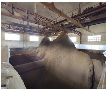
Un nouvel espace musée va être inauguré cette année : il s'agit de l'accumulateur de minerai de style Art nouveau construit par Édouard Zublin.
