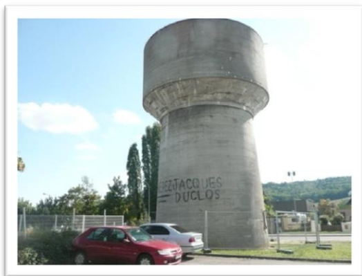
Le château d'eau disparaîtra bientôt du paysage.
