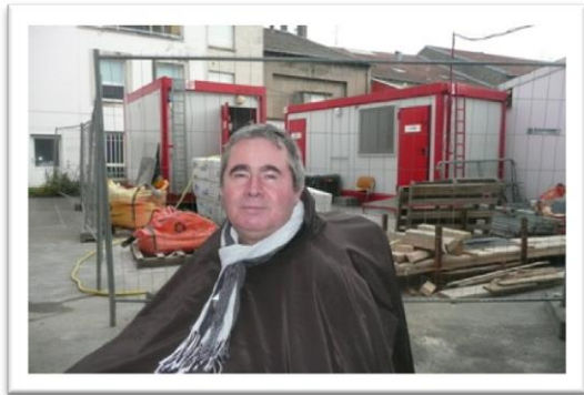
Etienne Thil devant le chantier de la mairie.
