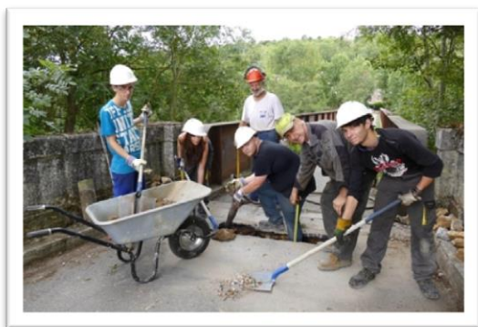
Un chantier qui permet aux jeunes de mettre en pratique leurs acquis
