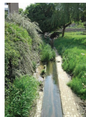
Effort d'esthétisme apporté à la canalisation du Viterne, Bainville-sur-Madon
