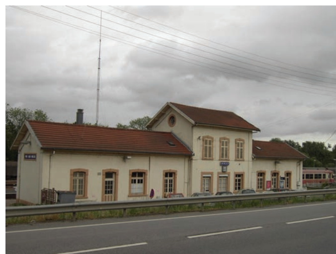
Gare voyageurs et abords peu entretenus, Pont-Saint-Vincent
