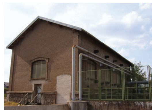
Maison éclésièrre, Messein
