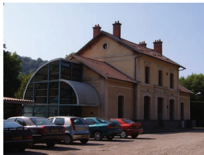
Ancienne gare reconvertie en salle polyvalente, Maron
