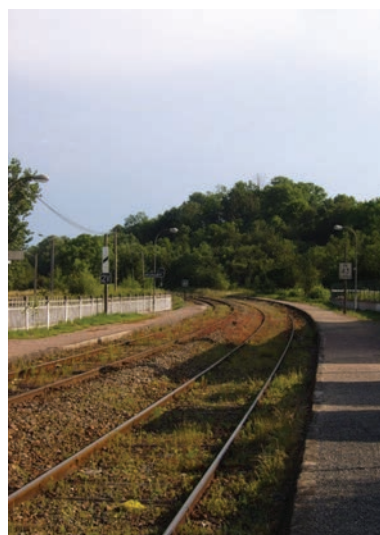
Voie ferrée voyageurs et marchandises, Xeulley
